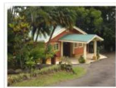
Instalaciones Centro de Capacitación La Catalina
